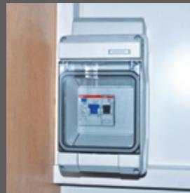
Verteilerkasten mit FI und
