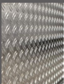
Bodenplatte mit Aluriffelblech belegt
